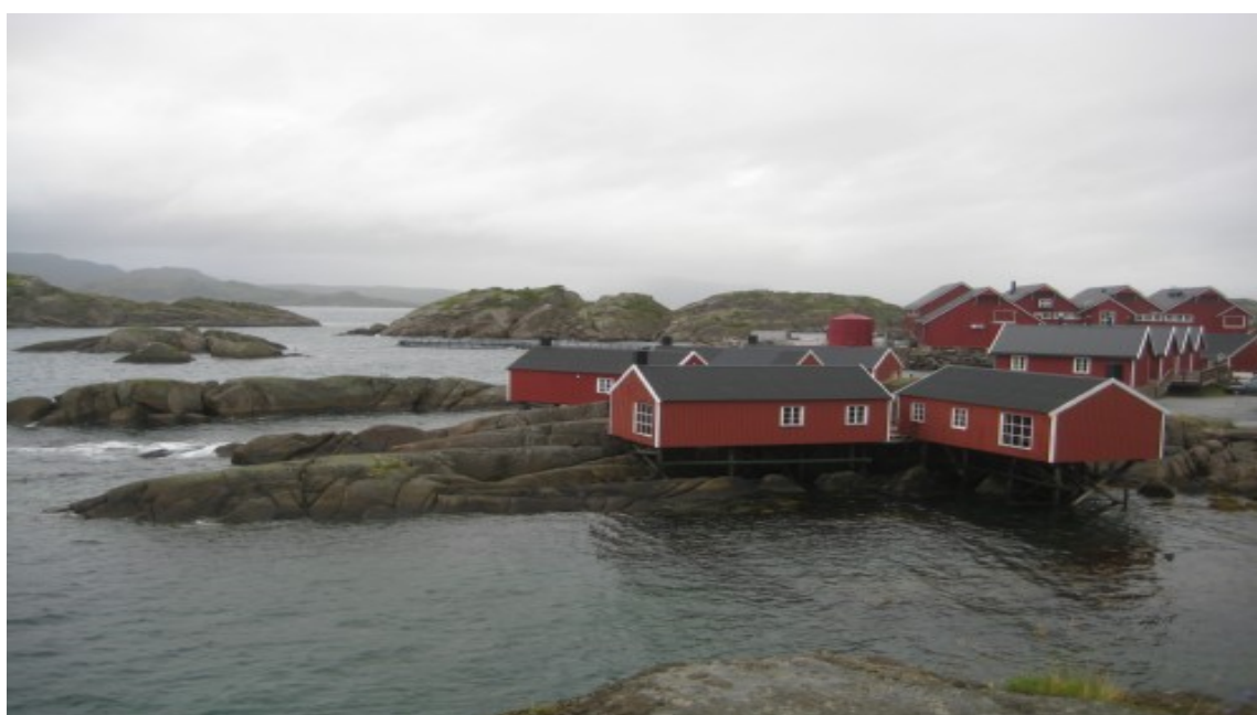
Mortsund E villaggio di pescatori trasformato in al-ergo
